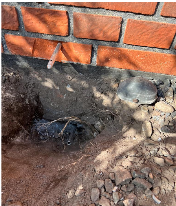
Foto 5: Etablering af O16. Bemærk udluftning fra mulig tank til højre.
