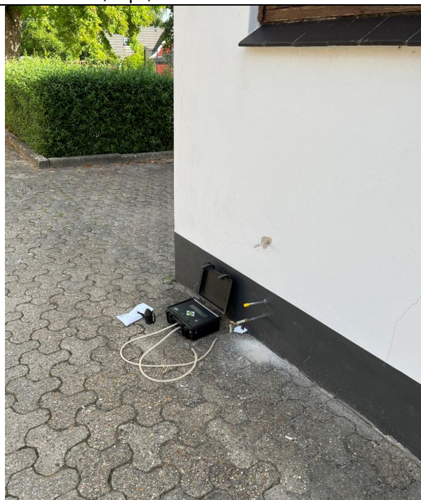
Foto 4: Kulrørsprøver. O10 set fra sydvest. Øverst ses boring indefra over gulv. Nedenunder ses sonder i 2 niveauer.
