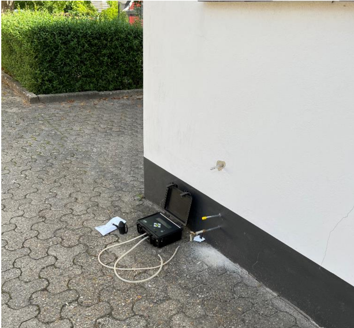
Figur 7: Billede af nordvestlige hjørne af TESTHUSET.
