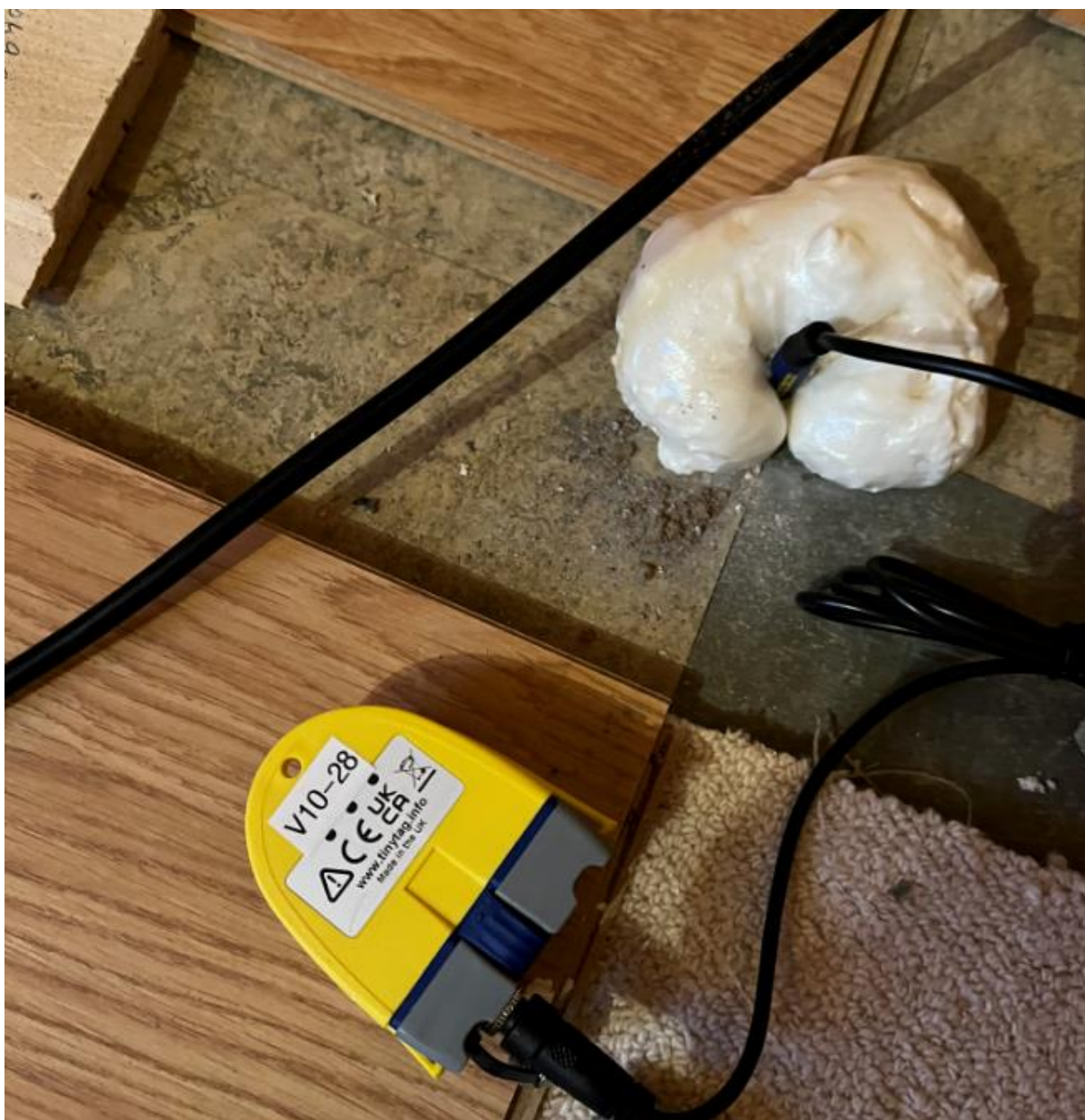
Figur 9: Eksempel på montering af temperaturføler under gulv, i dette tilfælde TinyTag, T6.
