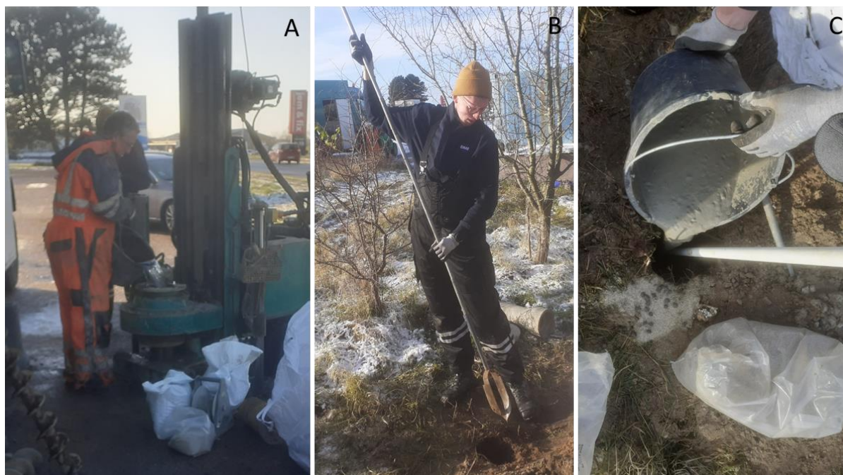
Figur 4: Etablering af borer til luftprøvetagning. A) Tilførsel af vand til traditionel boring med bentonit pellets. B) Etablering af håndboring. C) Tilførsel af grout til afpropning af håndboring.
