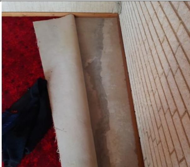
Foto 3: Til højre for MP1002, ses markant indtrængningsvej via revne i gulv (P1).
